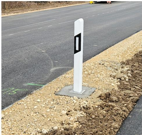
Abbildung 3: (Beispiel) Leitpfostenfundament mit Hülse und Leitpfosten
