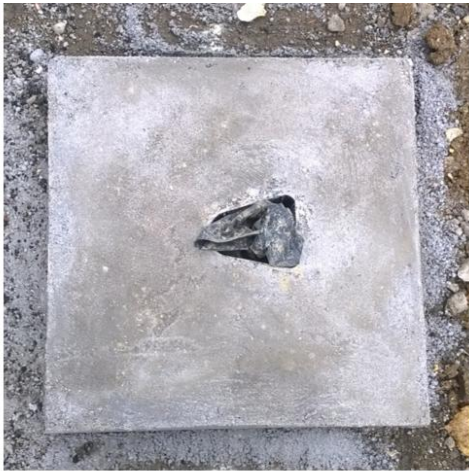
Abbildung 1: (Beispiel) Draufsicht auf Leitpfostenfundament mit Hülse
